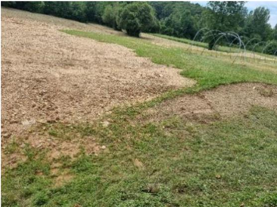
Nous avons reçu du remblai pour ajouter dans le prolongement sur le côté de la salle des fêtes en prévision de la pose d'une structure métallique avec toiture photovoltaïque.
